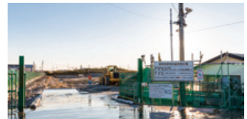
施設入口・トラックスケール
