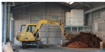
コンクリート固化
