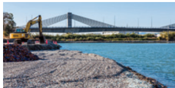
埋立作業風景
