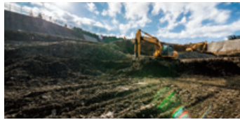
埋立作業風景
