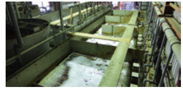
排水処理施設
