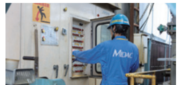
凝集沈殿処理制御装置
